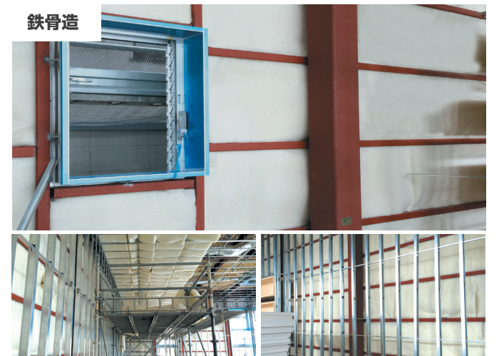
株式会社 三和リース 防災情報館 (山梨県) / 株式会社 早野組 施工
